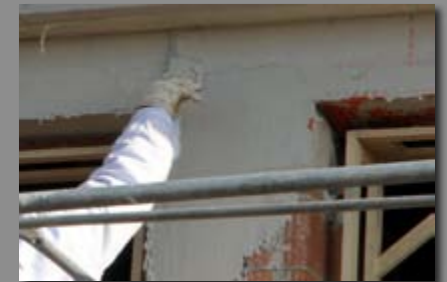
i) Endschicht aufspritzen und glattziehen
