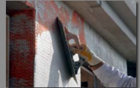
i) Endschicht aufspritzen und glattziehen
