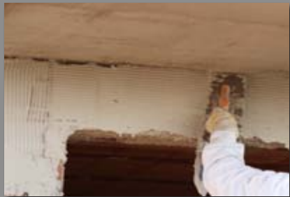
c) Erste Mörtelschicht plan abziehen
