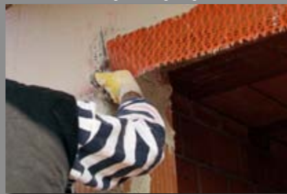
f) EQ-Grid so schneiden, dass Überlappungen an den Laibungen umgelegt werden können.
