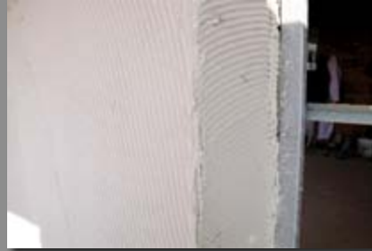
e) EQ-Grid eindrücken und Mörtel durch die Maschenfenster verstreichen
