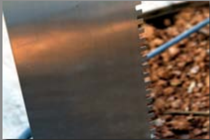
c) Erste Mörtelschicht plan abziehen
