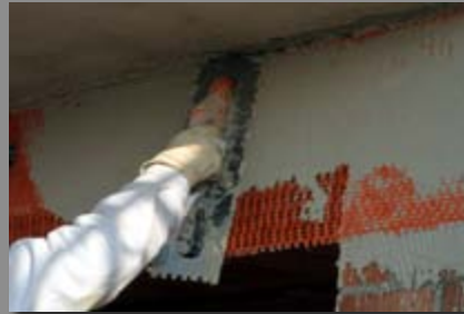
f) EQ-Grid so schneiden, dass Überlappungen an den Laibungen umgelegt werden können.
